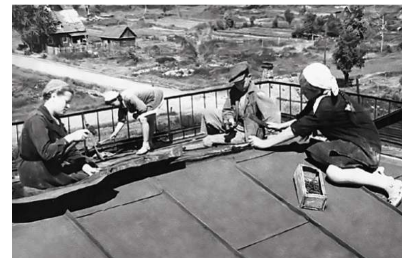
Школьники восстанавливают здание школы №402 к 1 сентября. 1944 г.
