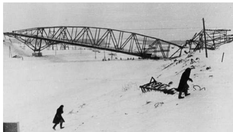
Разрушенный мост через Канал Москва–Волга в районе г. Яхромы. Декабрь 1941 г. (Фото из фондов МБУ «Музей-заповедник «Дмитровский кремль»)
